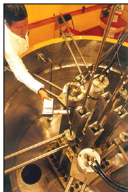
Boca del reactor RP-0 en la sede del INPE en San Borja, Lima, Perú. Fue la primera obra nuclear exportada por la Argentina, y con una importante participación de la entonces recién fundada INVAP.
