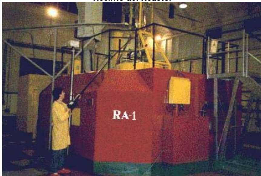
Recinto del Reactor
